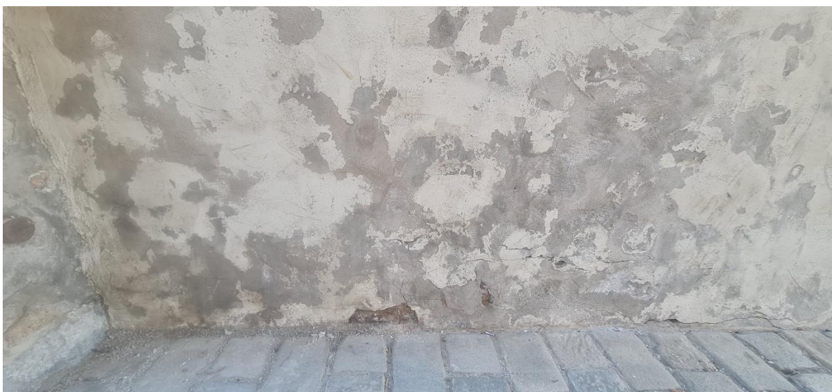
Průjezd – defekty omítky Stav před zahájením práce Brána Matky Boží v Jihlavě
