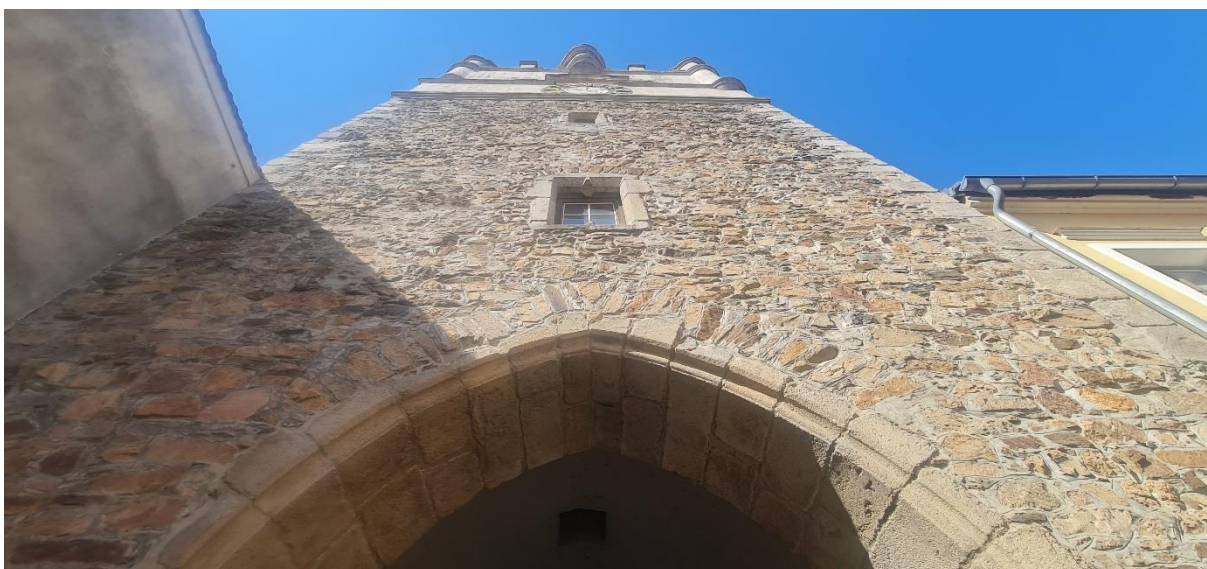
Portál – defekty kamene a spárování Stav před zahájením práce Brána Matky Boží v Jihlavě
