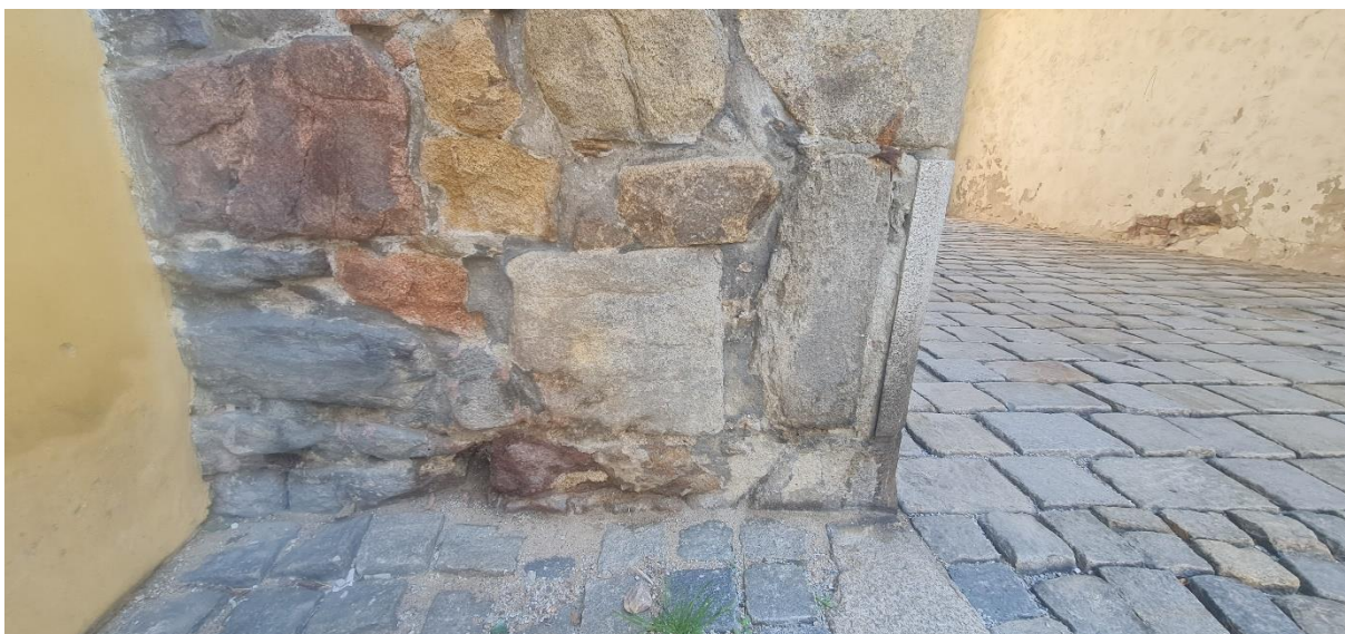
Zdivo – defekty portálu a spárování Stav před zahájením práce Brána Matky Boží v Jihlavě
