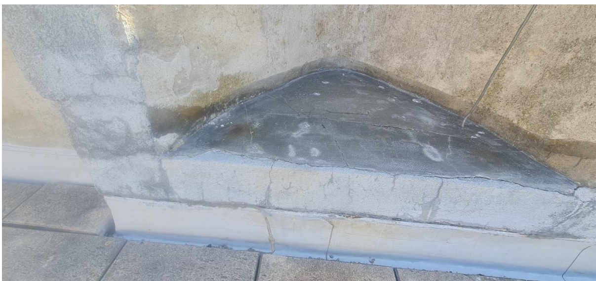
Atika – defekty omítky a zdiva Stav před zahájením práce Brána Matky Boží v Jihlavě
