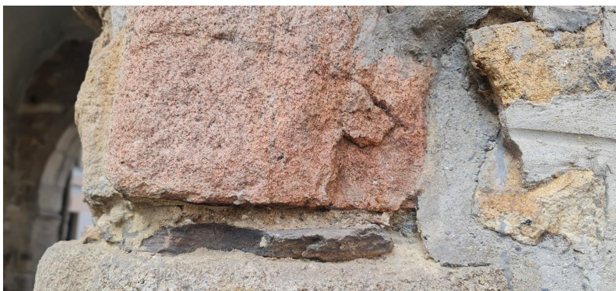
Zdivo – defekty kamene a spárování Stav před zahájením práce Brána Matky Boží v Jihlavě
