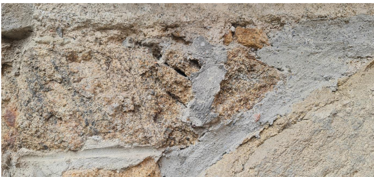
Římsa – defekty kamene a spárování Stav před zahájením práce Brána Matky Boží v Jihlavě
